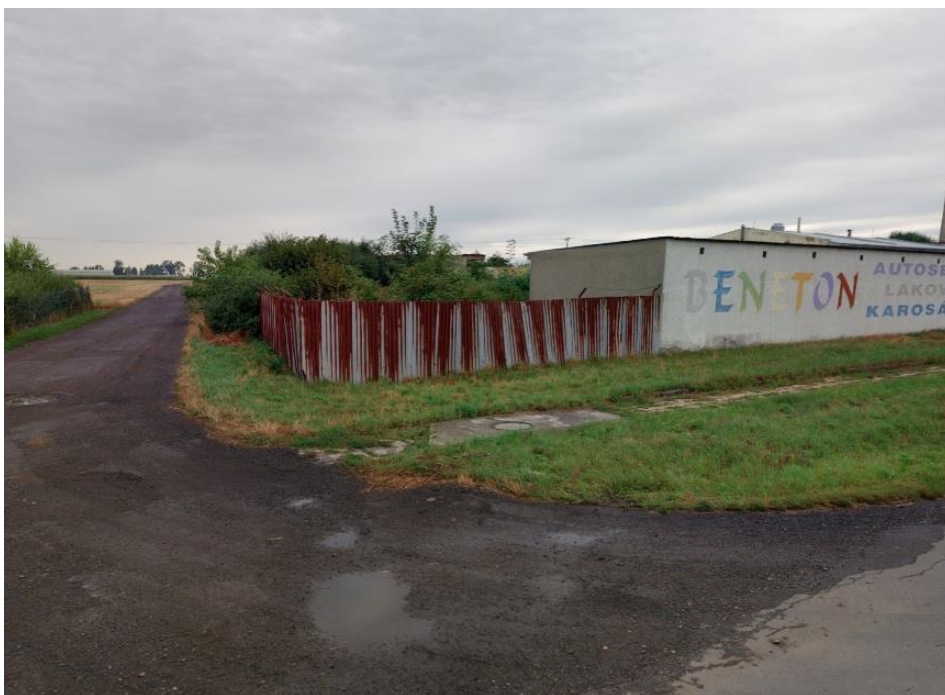
Obr. č. 7 Oplocení pravé strany z vlnitého plechu + vrcholová ochrana.
