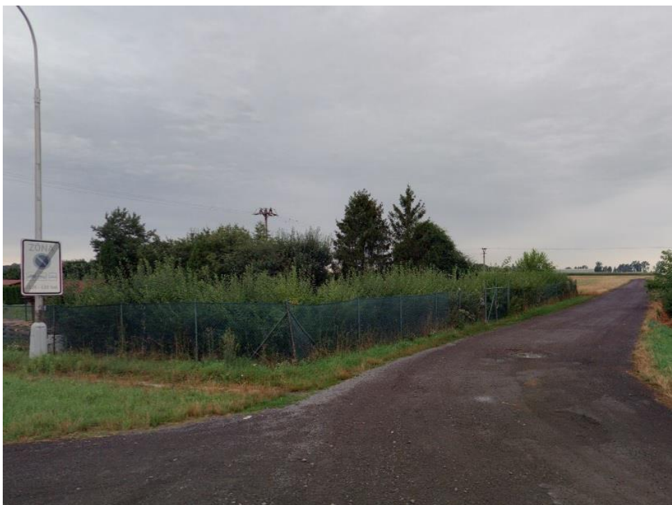
Obr. č. 6 Oplocení levé strany z rolovaného pletiva + PVC, vjezdová brána.
